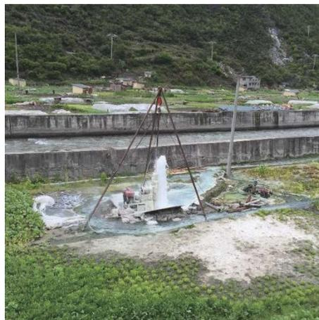
图1 川藏铁路沿线典型钻孔自流现象
